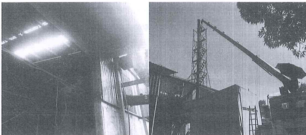
Hình 1: Tháo dỡ lò đốt công suất 200kg/giờ
